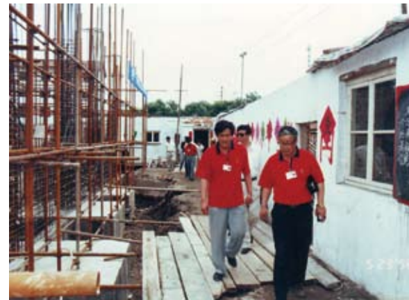
图为1997年7月，付玉成同监督员代表一起在贻成公司开发建设的中心北里小区工地进行检查情景。右二为付玉成。
